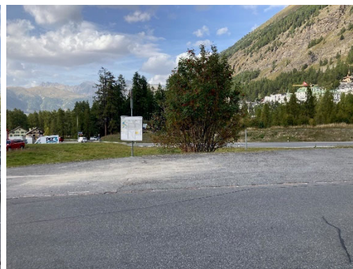
Abbildung 36: Mangelhafter Ausbau der Bushaltestelle Gitögla
