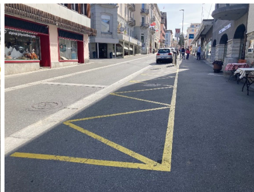
Abbildung 38: Mangelhafter Ausbau und ungünstige Lage der Bushaltestelle Rondo
