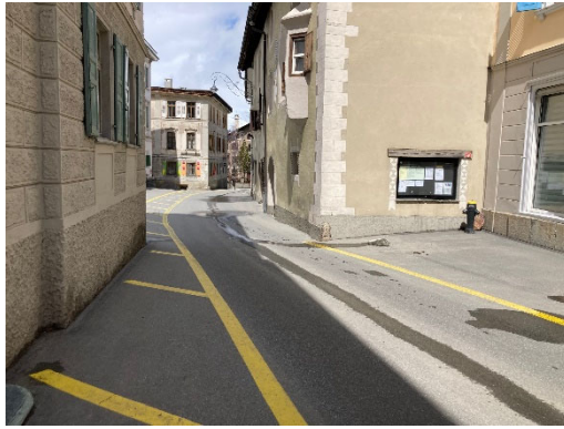
Abbildung 25: Enge Platzsituation im historischen Ortsteil Laret; der Fussverkehr wird mit farblichen Längsmarkierung geführt
